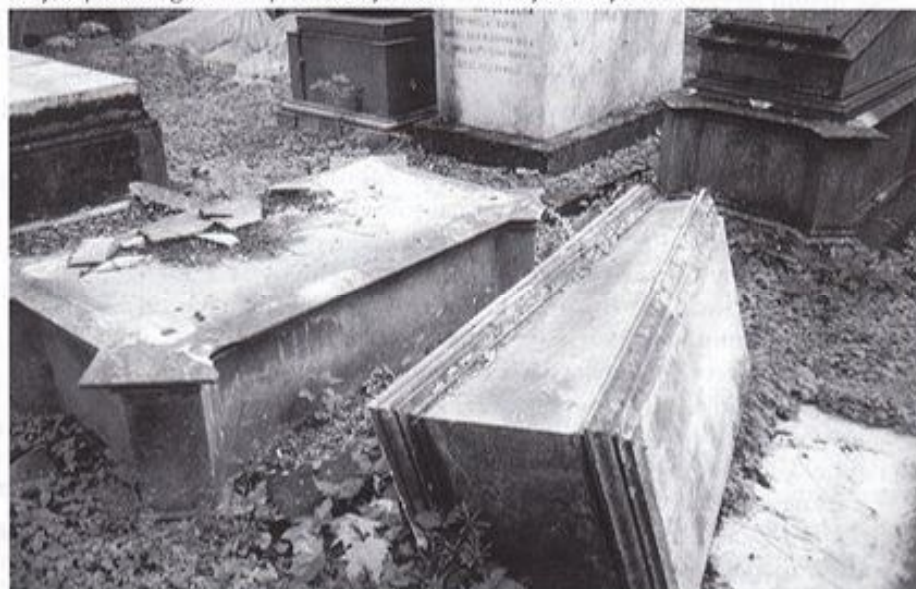
Zniszczony przez złodziei nagrobek, którzy pozbawili go lwich łap.
